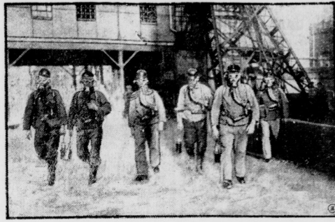
Retungsmannschaften mit Drägerischen Rettungsapparaten ausgerüstet.
