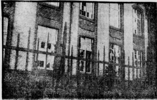
Durch den Luftdruck zerstörte Fenster in der Straßenfront des Werkes, der Explosionsplätte und der Wirtshaus entgegengesetzt.
