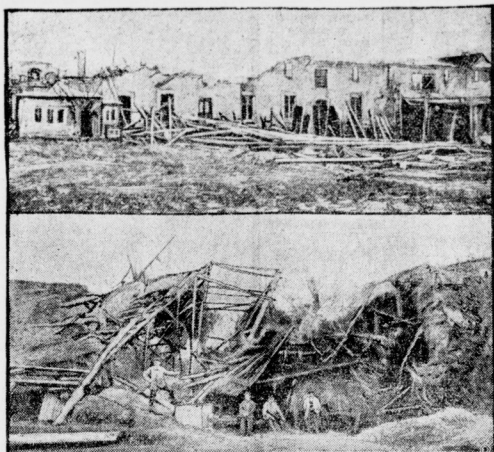
Oben: Ein vollständig zerstörtes Fabrikgebäude in Herten. Unten: Eine mit Korn vollgefüllte Säcke, die durch ein Einwirken der Mauer und des Daches dem Erdboden gleichgemacht wurde.
