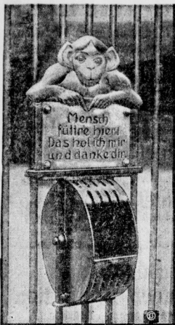
Das neue Hofpaletis im Berliner Zoo. Eine originelle Futterstelle für die Affen.
