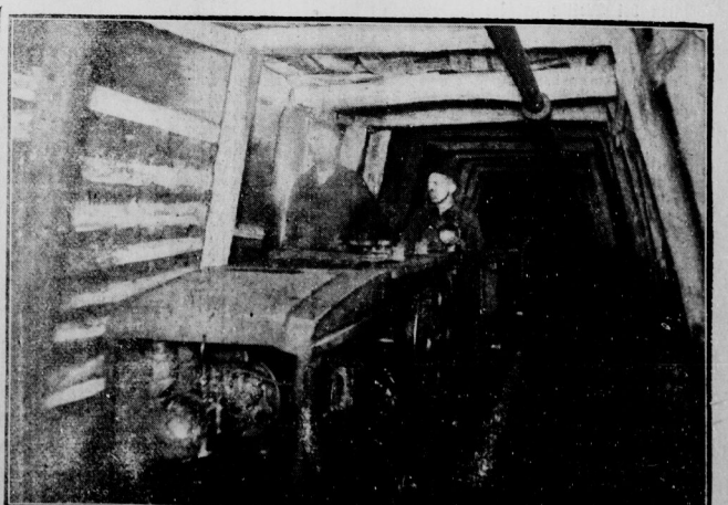
Benzol-Loomotivförderung an der 120 m Sohle des Steinkohlenwerks Plöb G. m. b. H.
