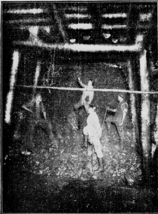
Vortreiben einer Strecke in dem 3 m mächtigen Flöz auf dem Steinkohlenwerk Pfuell G. m. b. H. (Phot. Professor Baumgärtel-Quastthal).
