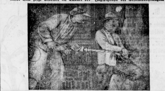
Unter Bild zeigt Arbeiter im Tunnel der Zugspitzbahn bei Gefährdungsarbeiten.
