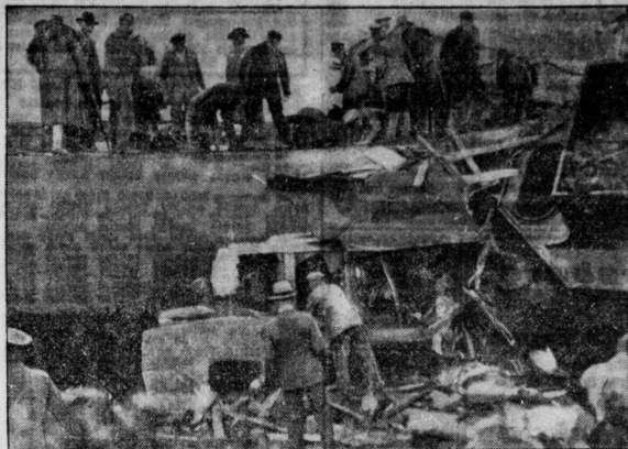
Bei dem schweren Eisenbahnunglück, das Sonntag morgen den Paris-Warschauer D-Zug auf dem Bahndamm bei Düren verunglückte, wurden 40 zum Teil schwer verletzt.
