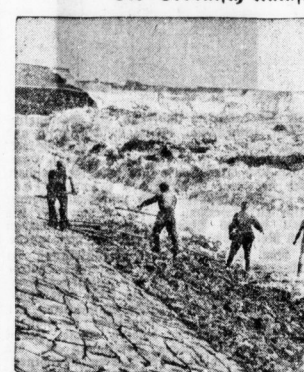
Die Erdrutsch-Katastrophe im Saaletal. Durch den gemäßigten Erdrutsch eines großen Kalbberges wurde am Mittwoch das gesamte Saaletal bei Bernburg verflüchtigt. Die dochmalige Gefahr an der Unfallstelle konnte durch angestrengte Tätigkeit des Staatlichen Arbeitsdienstes beseitigt werden. Die Saaleffahrt aber wird für Monate stillgelegt sein.
