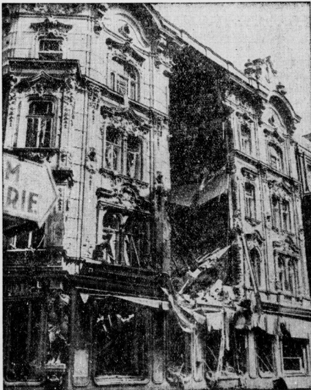
Das durch Explosion zerstörte Hotel „Europa“ in Brünn.
