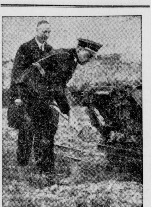
Darüber erster Spatenstich am Eiderdamme.
