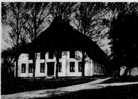
Norderdithmarscher Haus in Overwisch, Krs. Norderdithmarschen. Haus Thomson.
