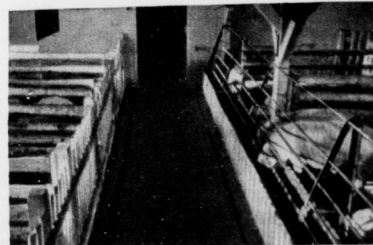
Ruhlsdorfer Stall, Innenansicht. Links: Zuchtbuchten; rechts: Mastbuchten. Futtertroch nicht durch Türen unterbrochen, Ausgang nach hinten zum Mistgang.
