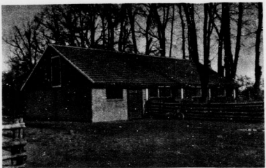
Ruhlsdorfer Stall, Außenansicht. Vorn: massiver Anbau für Lager und Dümpfraum.
