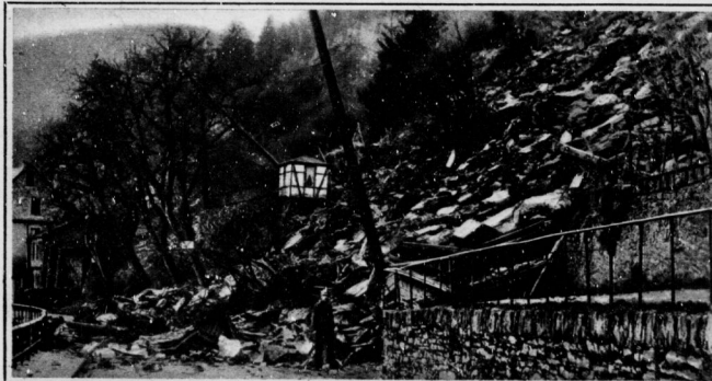
Der Bergsturz bei Cochem hat nach sachverständiger Schätzung rund 20 000 cbm Erd- und Felsmasse abrutschen lassen
