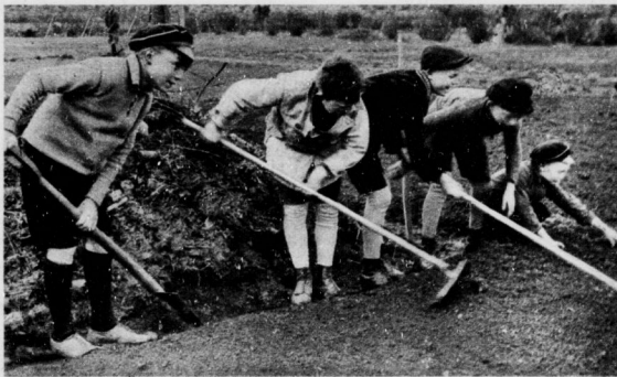
Mit Harke, Spaten und unbewehrten Händen geht's an die Arbeit
