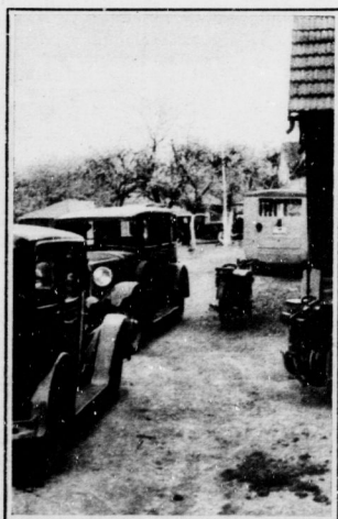
Parkplatz in Gierstädt
