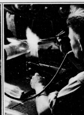
Der Hals wird zugeschmolzen
