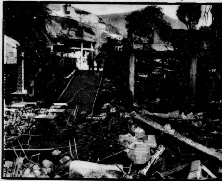
Unten: Nächtlicher Riesenbrand im Berliner Lunapark Ein Großfeuer vernichtete den einen der beiden Aussichtstürme, Restaurationsräume, Verkaufspavillons und einen Teil der Glückspielpassage.
