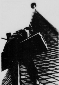
Mit dem Dachdecker auf dem Bartholomäusturm am Anger
