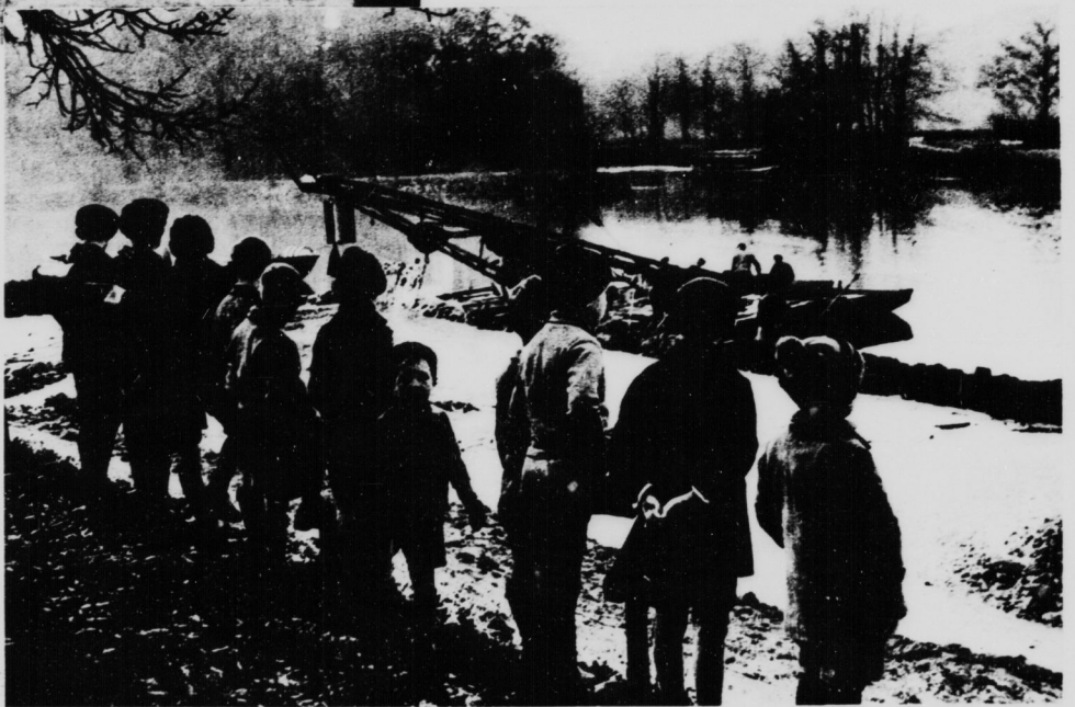
An der Gröllwitzger Brücke in Halle werden Baggerarbeiten vorgenommen und das Ufer entschlammt und aufgeschüttet
