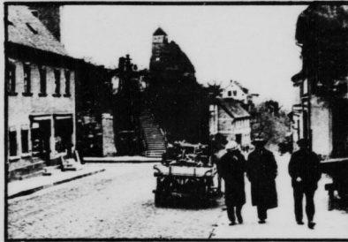
In Eilenburg Im Hintergrund die alte Sorbenburg
