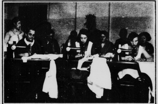
Für die Winterhilfe wird gearbeitet! Im alten Elektrizitätswerk in Glaucha (Halle)
