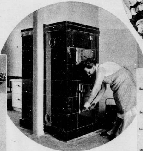
Im Zeichen der Brennstoff-Ersparnis Um möglichst wenig Braunkohlenbriketts zu verbrauchen und Arbeit zu ersparen, hat man in Neubauten vielfach durchgebaute Kachelöfen, die gleichzeitig 2 Zimmer heizen. — Der Durchschnitt rechts zeigt die geschickte moderne Zugführung, die diese Brikettersparnis ermöglicht
