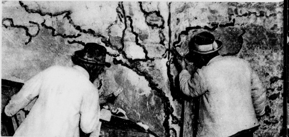
Unten: Das ist der große Riß, der repariert werden muß
