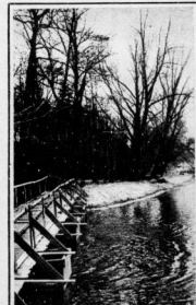
An dieser Stelle des Gotthardtteiches wurde eine neue Brücke gebaut. Die Verbindung zwischen beiden Ufern wurde einstweilen durch eine Pontonbrücke hergestellt
