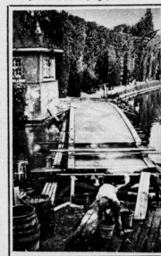
An einer anderen Ecke des Gotthardtteiches entstand als Verbindung zweier Uferwege eine massive Betonbrücke
