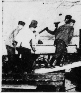
Pioniere bringen schwere Tragerteile, die mit dem Schneidbrenner in metergroßen Stücken geteilt wurden, an Land. (Bilder [3]: Billhardt.)
