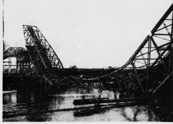
Die zusammengebrochene Brücke. (Vorn der Mast des gesunkenen Kahnes.)
