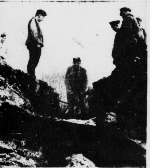
Schwere Arbeit im harten und zähen Beton. Hier: Büßhardt.
