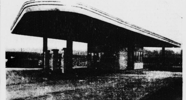
Die neue Großtankanlage an der Autobahnanchlussstelle Merseburg — Leipzig. (S.-Z. Bilder)
