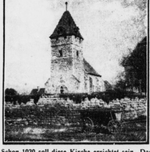
Schon 1030 soll diese Kirche errichtet sein. Das wirkliche Baujahr ist jedoch unbekannt.
