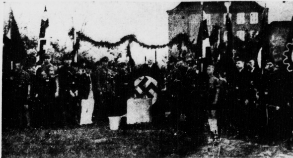
Die Feier der Grundsteinlegung. (Bilder: Moser.)
