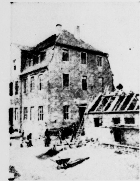
Neben dem sog. Schloß in Petersroda werden Stallgebäude zur Kleinviehhaltung errichtet.
