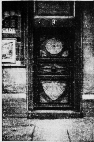
Die Haustür von außen.
