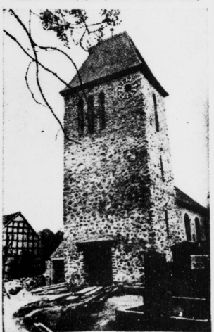
Ein Blitz zerstörte im vergangenen Jahr den Turm der Kirche zu Kossa in der Dübener Heide. Jetzt ist er wieder aufgebaut, und nach dem Einbringen der Ernte soll er eingeweiht werden. Hübsch fügt sich der neue Bau dem alten an.
