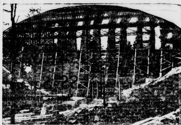
Deutschlands größte Bogenbrücke aus Eisenbeton im Bau
