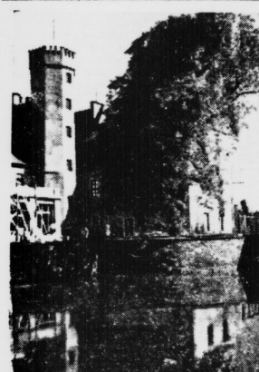
Das schöne alte Wasserschloß Reinsdorf bei Landsberg, vom Graben aus gesehen.
