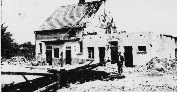
Das durch Blitzschlag zerstörte Stallgebäude des Siedlers E. Pohlmann, Vogelsang.
