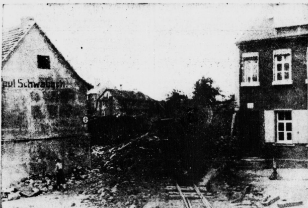
Eine Feldbahn befördert die Schutt- und Erdmassen vom Abbruchgebiet auf die tiefer gelegenen Teile des Geländes.
