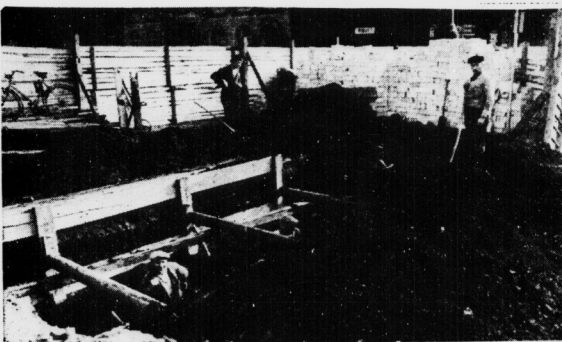
Die tiefe Baugrube am Hallmarkt.
