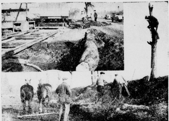
Oben links: die Bauarbeiten zur Verbreiterung der Straße an Rusesches Hof. Unten: hinter dem „Rosengarten“ werden die Bäume mit Hilfe von Pferden aus dem Boden gerissen. (Bilder: Ziegler.)
