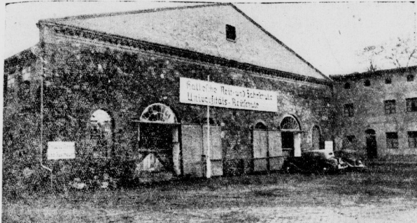
In dieser Halle entsteht die neue Reitbahn.
