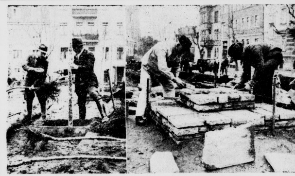
Arbeiten am Wettinerplatz machen Fortschritte Die Umgestaltung des Wettinerplatzes und seine Ausgestaltung zum Kinderspielplatz machen Fortschritte. Rund um den Spielplatz werden wie unser linkes Bild zeigt, Rotorndornbäume gepflanzt. Auf dem rechten Bild ist man beim Ban eines Ecksteines aus Kalkstein, der auf dem Galgenberg gebrochen wird. Diese Ecksteine werden später mit Blumen besetzt. (Ziegler.)
