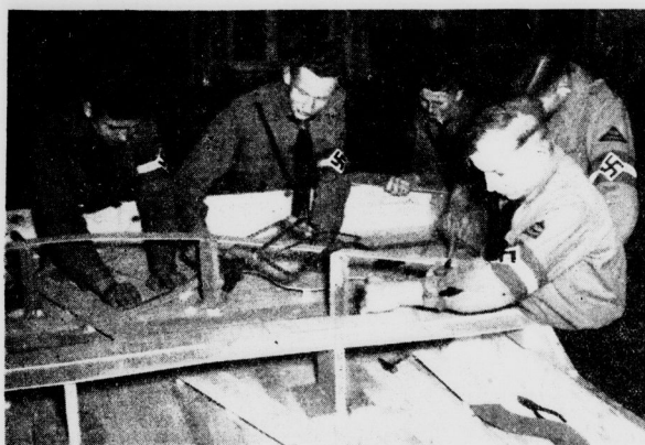
Der Verkehrstisch im Entstehen.
