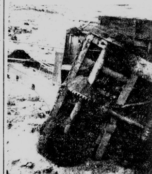
Die Unglücksstelle in einem Meer von Schlamm.
