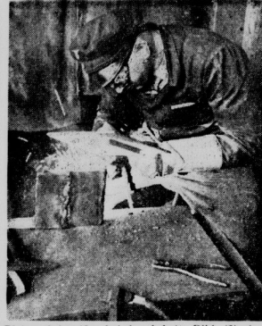
Elektro-Schweißer bei der Arbeit. Bild: Ziegler.
