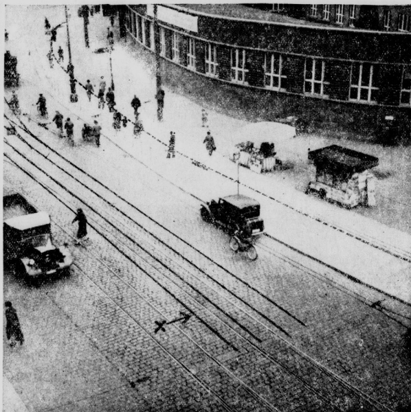
So wird die Straße am Steintor nach der Verbreiterung aussehen. Die gestrichelte Linie zeigt das Stück des Bürgersteiges, das zu der Straße hinzu genommen wird. Die Linien in der Mitte der Straßenbahnleiße an.
