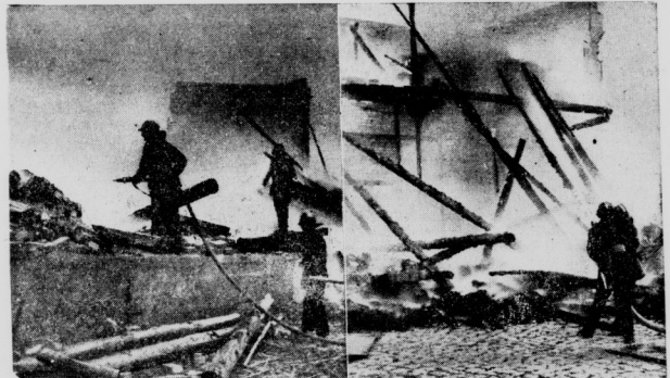
15 Schlauchleitungen waren nötig, um eine weitere Ausbreitung des Feuers zu verhindern.
