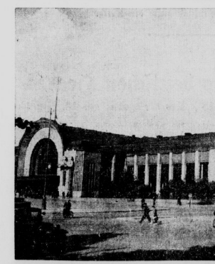
Der Hauptbahnhof von Helsinki. Ein klassisches Beispiel neufinnischer Baukunst. (Bild: Bögelund-Helsinki.)
