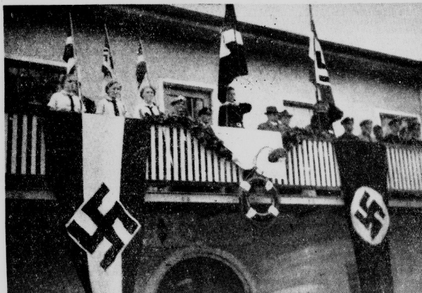
Wie die „Saale-Zeitung“ bereits berichtete, wurde das neue Heim der Marine-III, in Ammendorf, das den Namen „Gorch-Fock-Heim“ erhielt, seiner Bestimmung übergeben. Die Aufnahme zeigt einen Blick auf die Vorderfront während des Weiheaktes. (Bild: Seiert.)
