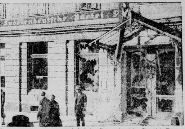
So sieht heute die Hauptgeschäftsstelle der Sudetendeutschen Partei in Eger aus. Mit echt russischer Zerstörungswut haben die Tschechen in der Hauptgeschäftsstelle der SDP, im Hotel „Viktoria“ in Eger gehaust. Heute bietet das Haus diesen graugrünen Anblick. (Scherl-Bilderdienst-M.)
