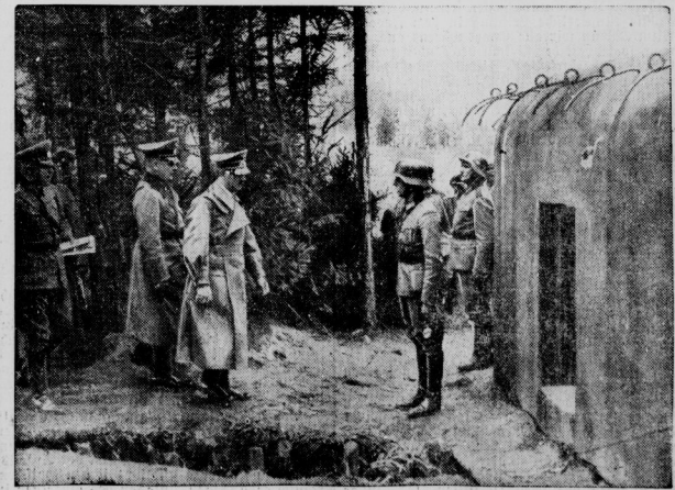
Adolf Hitler besichtigte die tschechischen Befestigungen Während seiner Reise durch die II. Zone nahm Adolf Hitler auch eine Besichtigung der tschechischen Befestigungswerke vor, in denen in geradezu widernatürlicher Weise deutsche Land gegen Deutsche verteidigt werden sollte. (Scherl-Bilderdienst-M.)
