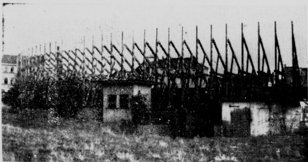
Die letzten Reste der Rennbahn vor dem Abbruch.
