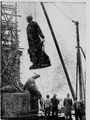
Das bekannte Bismarck-Denkmal in Berlin, das ebenso wie die Siegestaube vom Königplatz nach dem Großen Stern „umzieht“, ist soeben vom Sockel abgenommen worden. Unser Bild zeigt die über sechs Meter hohe Statue am Flaschenzug während der Abnahme. (Scherl-Bilderdienst-M.)
