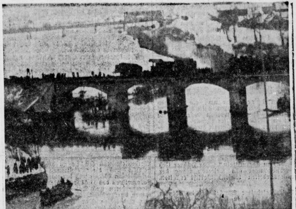
Die Unglücksbrücke bei Großheringen am ersten Feiertag vormittags. Man sieht die Lokomotive des Schnellzuges, der den Personenzug rammt, über dem zweiten Brückenpfeiler links. Der Tender ist aus den Gleisen gesprungen und hängt mit den Hinderrädern in der Luft. Im Wasser sieht man als dunkle Punkte die Räder des in die Saale gestürzten Personenzuges. Vor dem ersten Brückenpfeiler links ein Floß der Pioniere, die den Fluß absuchen. Ein weiteres Floß befindet sich gerade auf dem Wege zur Unglücksstelle.
