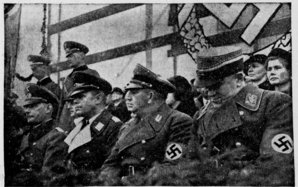
Richtfest der Heeres- und Luftnachrichtenschule.
