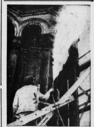
Mit Dampf und Salzsäure gegen das Rathaus. Die Reichshauptstadt „macht sich schön“ für die Olympischen Spiele. Um den Besuchern eine blitzblaue Fassade des Berliner Rathauses zu zeigen, wird diese mit Dampf und Salzsäure vom Schmutz befreit. (Scher-Bilderdienst-M.)
