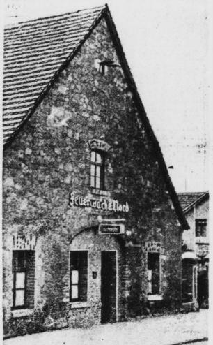
Hier ist die neue Feuerwache Nord untergebracht.
